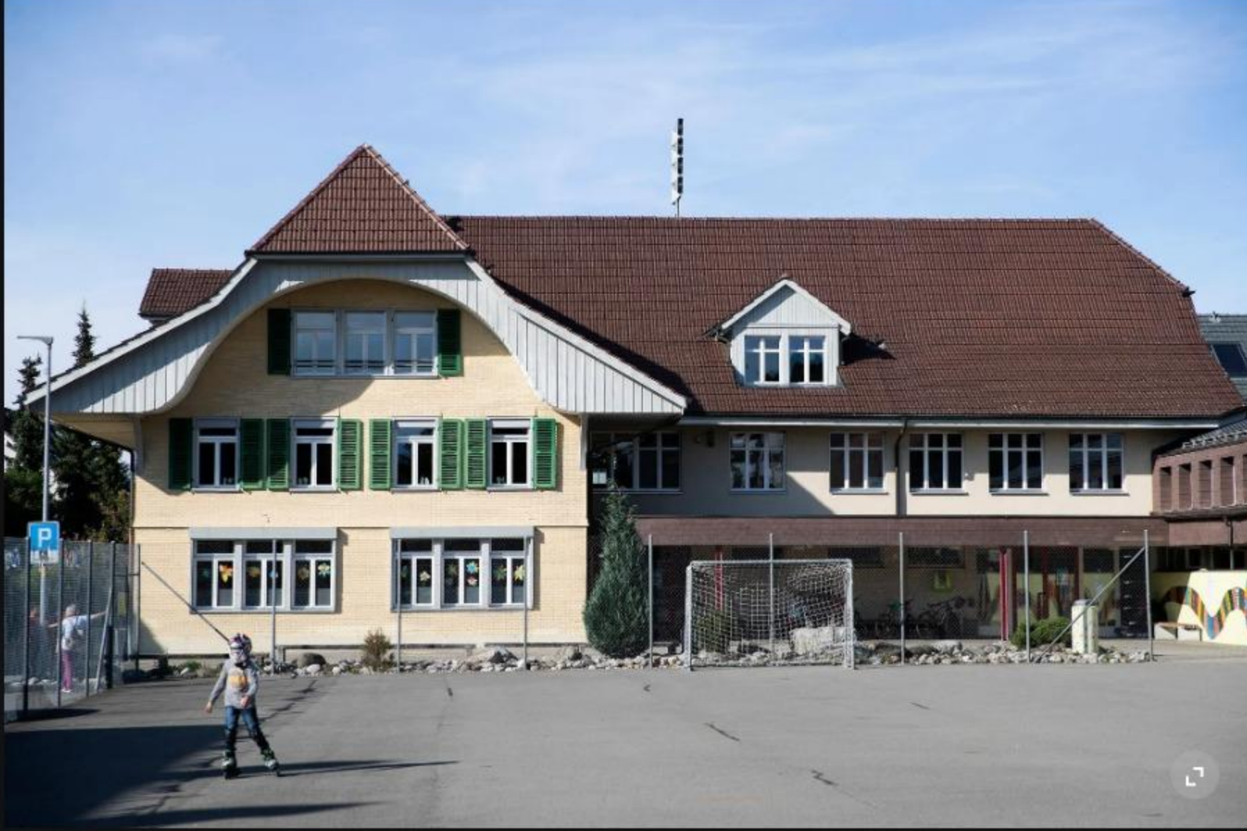
Im Schulhaus am Bach in Niederwischtrach werden auch in Zukunft Kinder unterrichtet. Das Gebäude kann noch 20 Jahre lang so weiterbetrieben werden.
